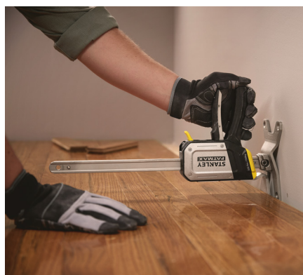
Pose de sol (parquet)
