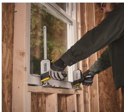
Pose de portes et de fenêtres
