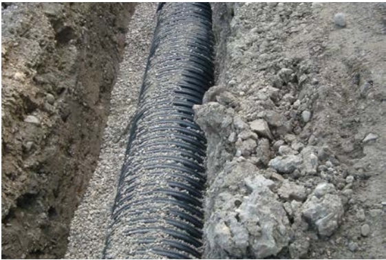
Fig. 07-3 Enrobage des canalisations RAUPIPEX
