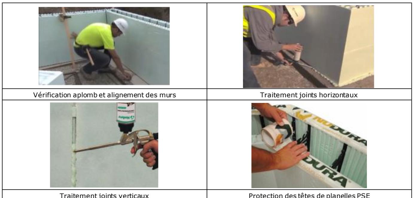
**Figure 14 – Mise en œuvre – préparation avant coulage du béton**
