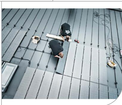
Modules solaires PREFALZ - Système photovoltaïque pour toitures à joint debout.
