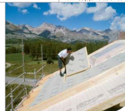
Afin d'isoler les habitats des régions aux conditions extrêmes, montagneuses ou venteuses, Recticel Insulation a développé Eurotoit® Montagne. Ce panneau d'isolation thermique destiné à l'isolation des toitures en pente par l'extérieur, est plus sécurisant grâce à son parement traité pour plus d'adhérence des chaussures de sécurité. Anti-réfléchissant, il limite également l'éblouissement et facilite ainsi la mise en œuvre par les équipes de pose.
