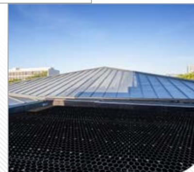
Système de rétention d'eau pour toiture terrasse composé de plaque alvéolaire pré-assemblées qui se superposent pour créer un circuit de rétention temporaire des eaux pluviales. Les modules peuvent également être utilisés pour installer un remblai allégé en toiture terrasse ou faire du lestage avec des gravillons dans le cas d'une isolation inversée : Une solution durable à l'heure où la gestion des eaux est une préoccupation essentielle.
