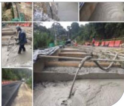
AEROLITHYS® est un béton allégé très basse densité (200 à 400 kg/m<sup>3</sup>) non structurel, prêt à l'emploi, fabriqué et pompé sur site. Il est utilisé en bâtiment pour la mise à niveau des sols et l'isolation et en travaux publics pour des remblais techniques.
