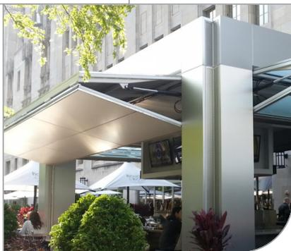
La porte relevante Bifold est un dispositif d'ouverture-fermeture sécurisant les bâtiments ou locaux commerciaux nécessitant une grande dimension d'ouvrant.
