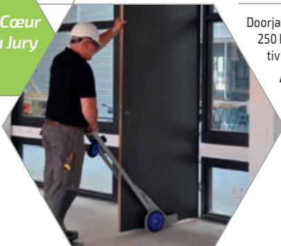
Doorjack et Doorjack XL : le chariot de manutention et de pose de portes jusqu'à 250 kgs, utilisable par une seule personne pour un gain de temps et de productivité tout en préservant l'opérateur de TMS.
